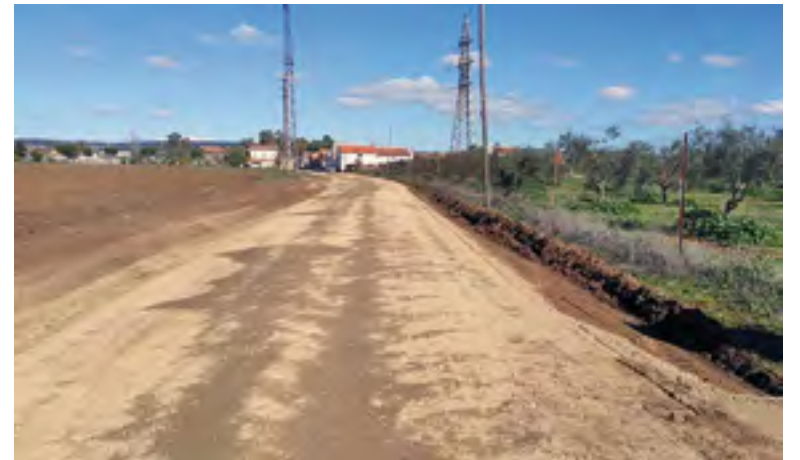
Camino Paseo del Merendero
